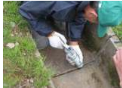
シーリング材充填
