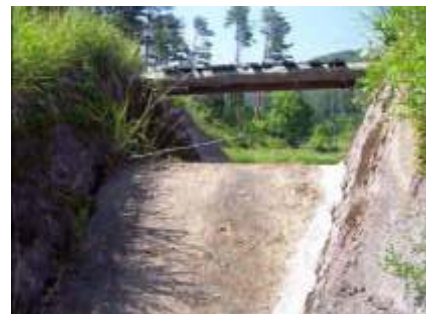
洪水吐の補修
