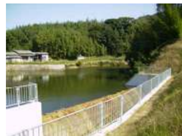
金網フェンスの 設置状況
