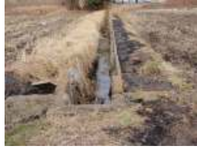
老朽化した水路（全景）
