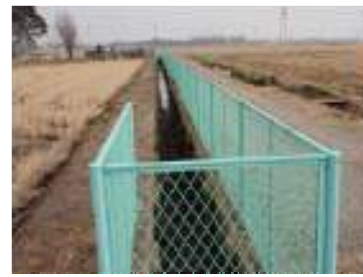
新たに設置された 金網フェンス
