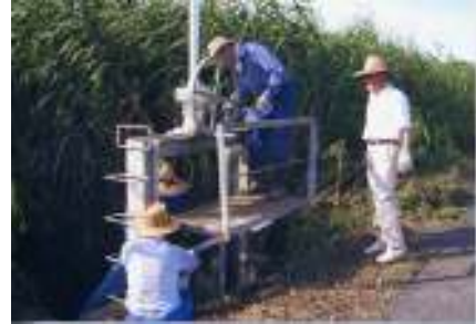
ゲートの点検
