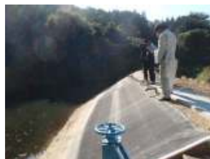
遮水シートの設置
