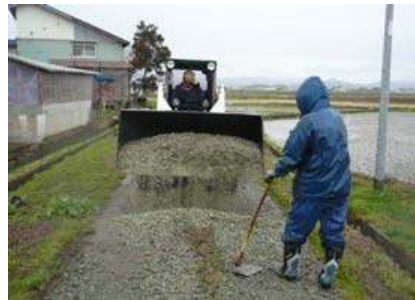
砂利の敷き均し
