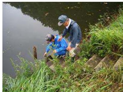
取水施設の点検
