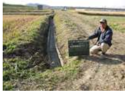
土側溝をコンクリート側溝に更新
