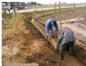
水路の再布設
