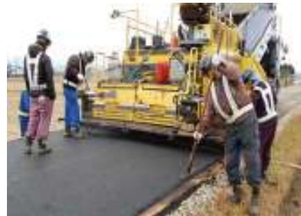
アスファルト舗装状況
