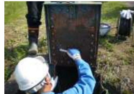
ゲートの補修状況
