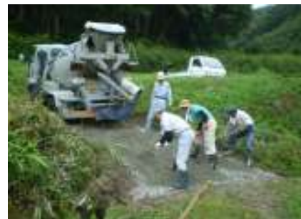
コンクリート舗装状況
