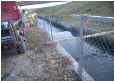
金網フェンスの 設置
