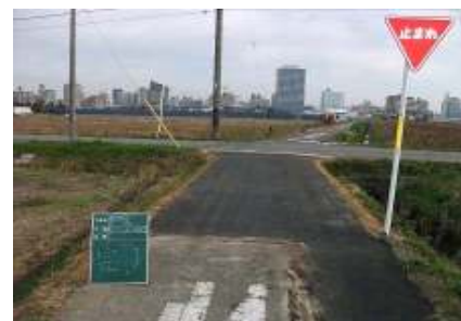
アスファルト舗装の打換え
