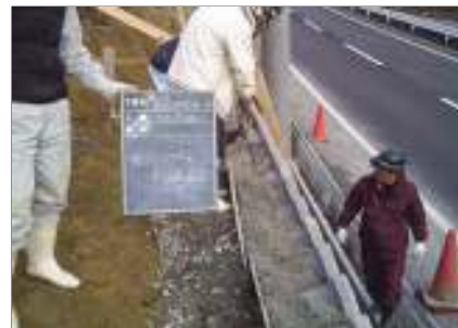
ブロック積みの施工
