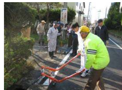
水路蓋の設置 (専用器具使用)
