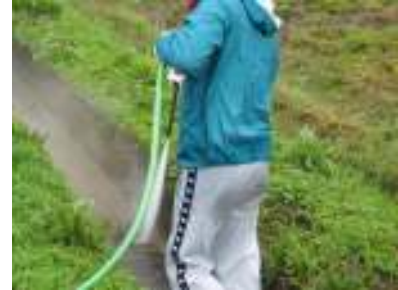
高圧洗浄機による 水路内の清掃
