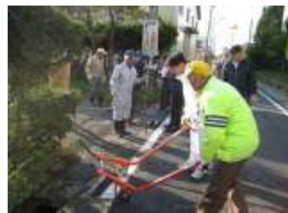
水路蓋の設置 (専用器具使用)
